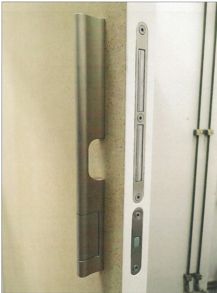
obr. 3 – magnetický blok, zámek a vnitřní madlo – stav WC zámku G 500 - odemknuto
