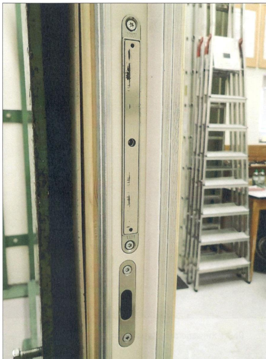
obr. 5 – Magnetic a protiplech WC zámku G 500
