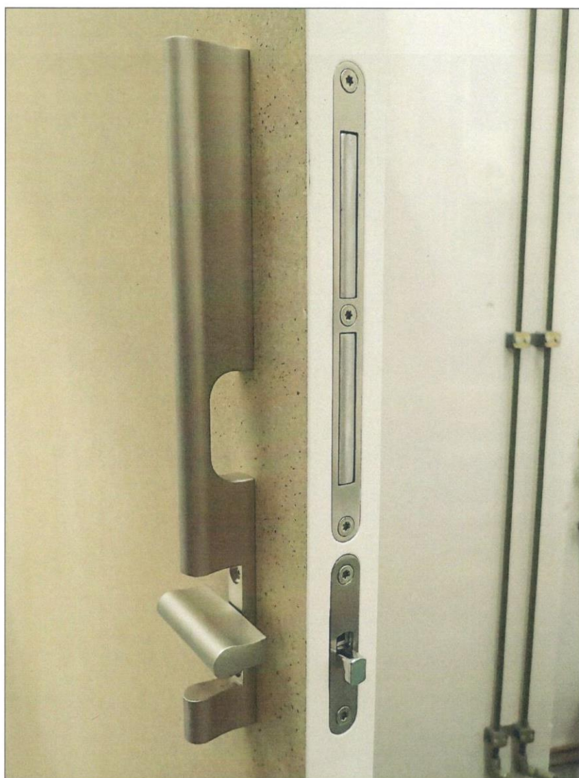
obr. 4 – magnetický blok, zámek a vnitřní madlo – stav WC zámku G 500 - zamknuto
